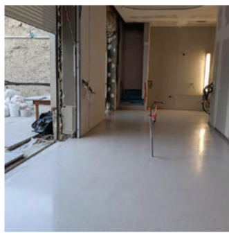
/// TECHNOSOL SUR CHAPE
