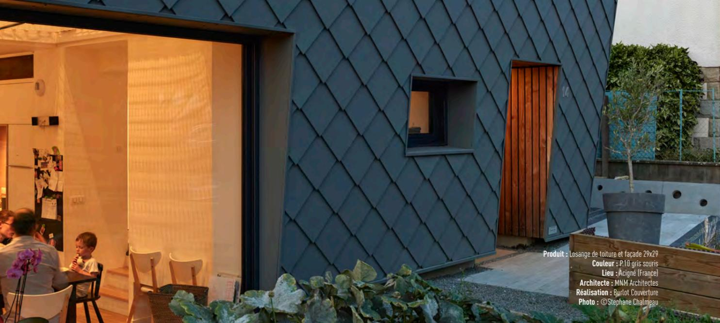
Produit : Losange de toiture et façade 29x29
