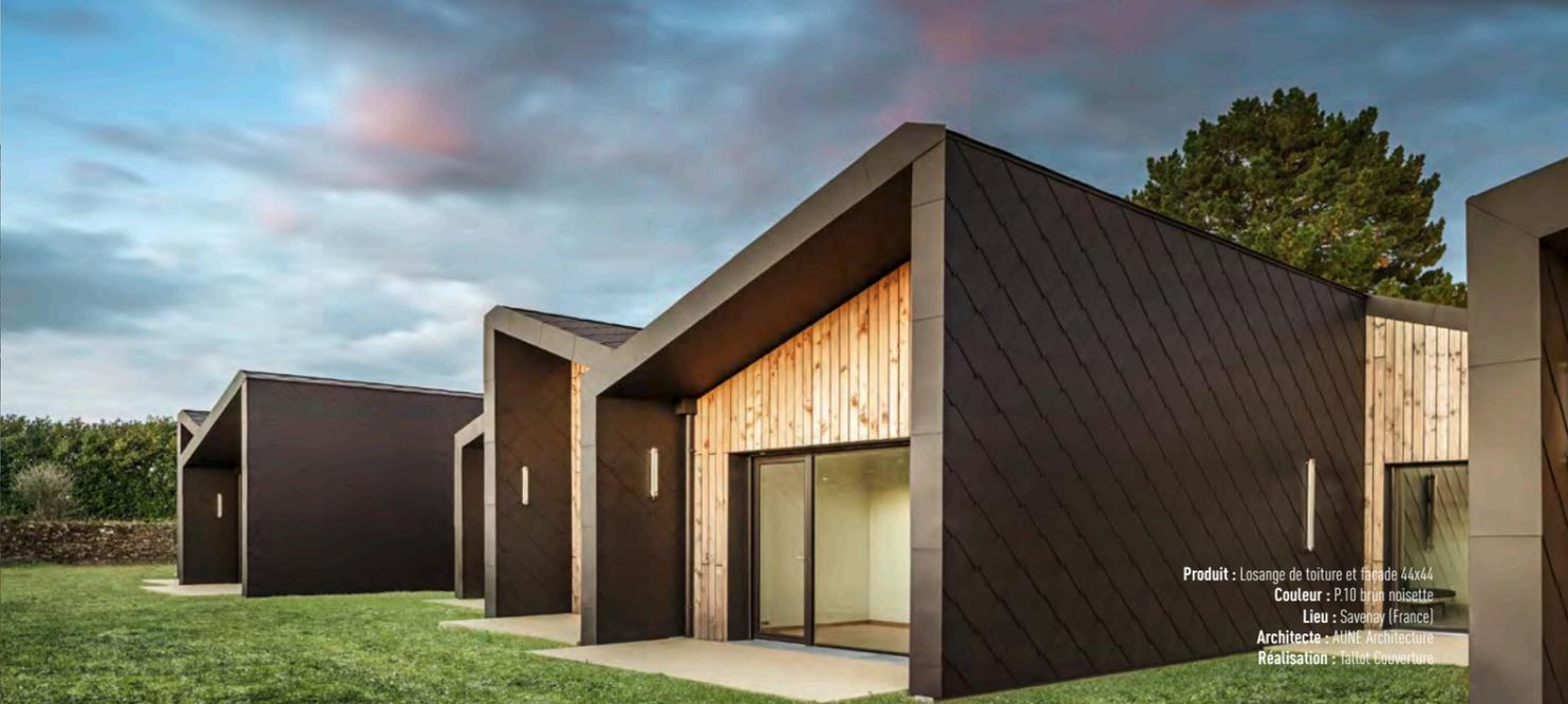
Produit : Losange de toiture et façade 44x44
