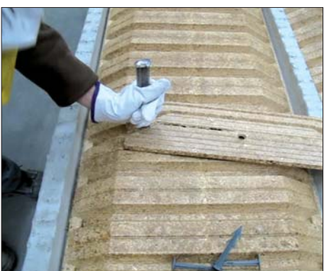
Séparation du tympan pour rupteur ES
