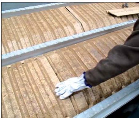
Emboîtement de deux EBS sans coupe du bouchon
