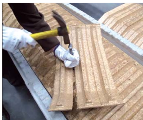
Coupe au burin ou au marteau (sécable)
