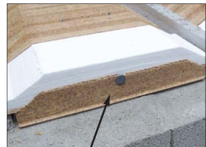
Tympans sécables incorporés dans le bouchon pour pose des rupteurs Stoptherm ES
