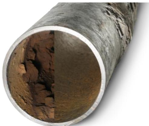
Figure 1: État avant et après fraisage mécanique
