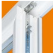
Verrouilleur automatique en partie haute d'un oscillo-battant
