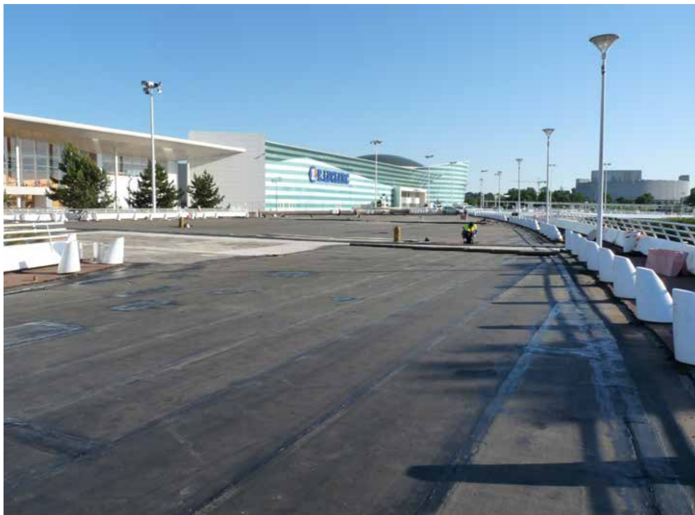
Parking Atlantis Étancheur: Euroétanche
