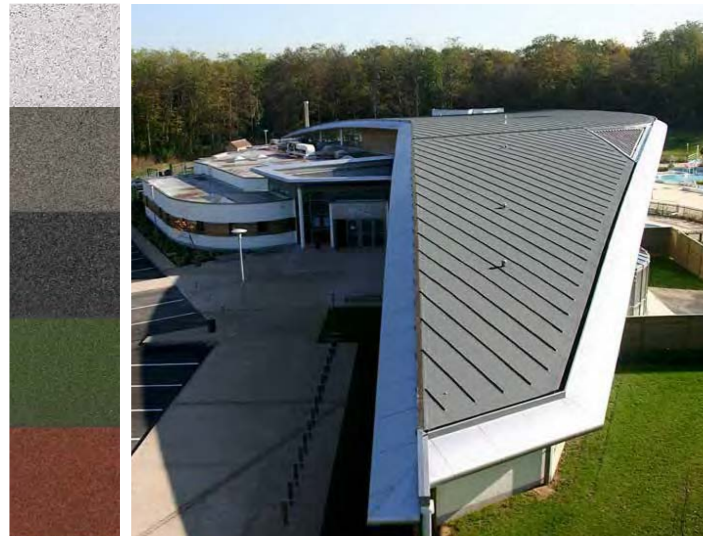
Piscine de Gouvioux Étancheur: Auobise du bâtiment
