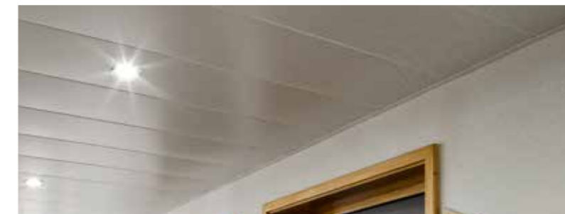
Plafond posé sur profils de rives apparents
