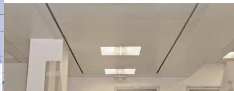
Plafond accroché sur profils de rives cachées
