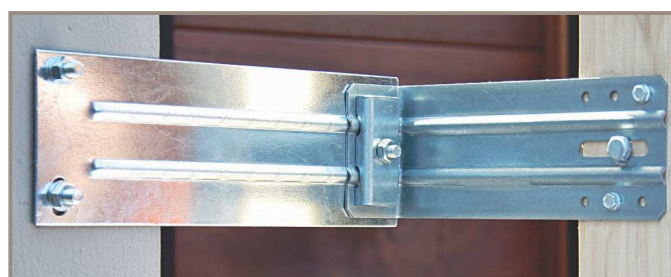
Fixation au mur porteur par 2 chevilles Ø 8.
