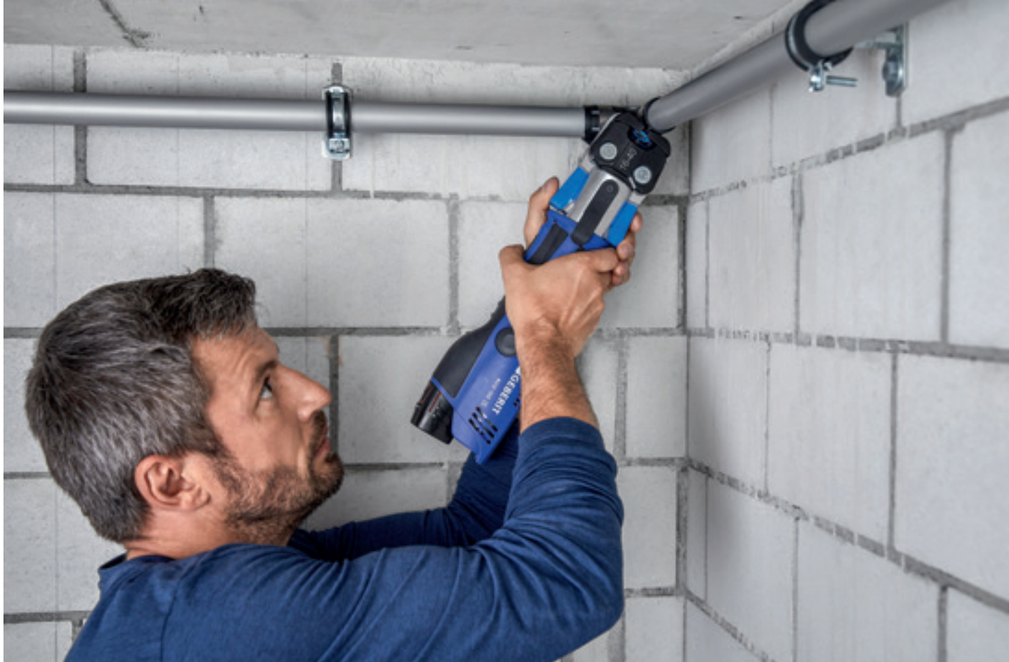
↑ Sertissage en toute sécurité même dans les endroits exigus ou difficiles d'accès. Les raccords rotatifs et l'absence de chaînes de sertissage garantissent une bonne posture de travail et simplifient la tâche même pour la pose en hauteur des tubes de grande dimension.
