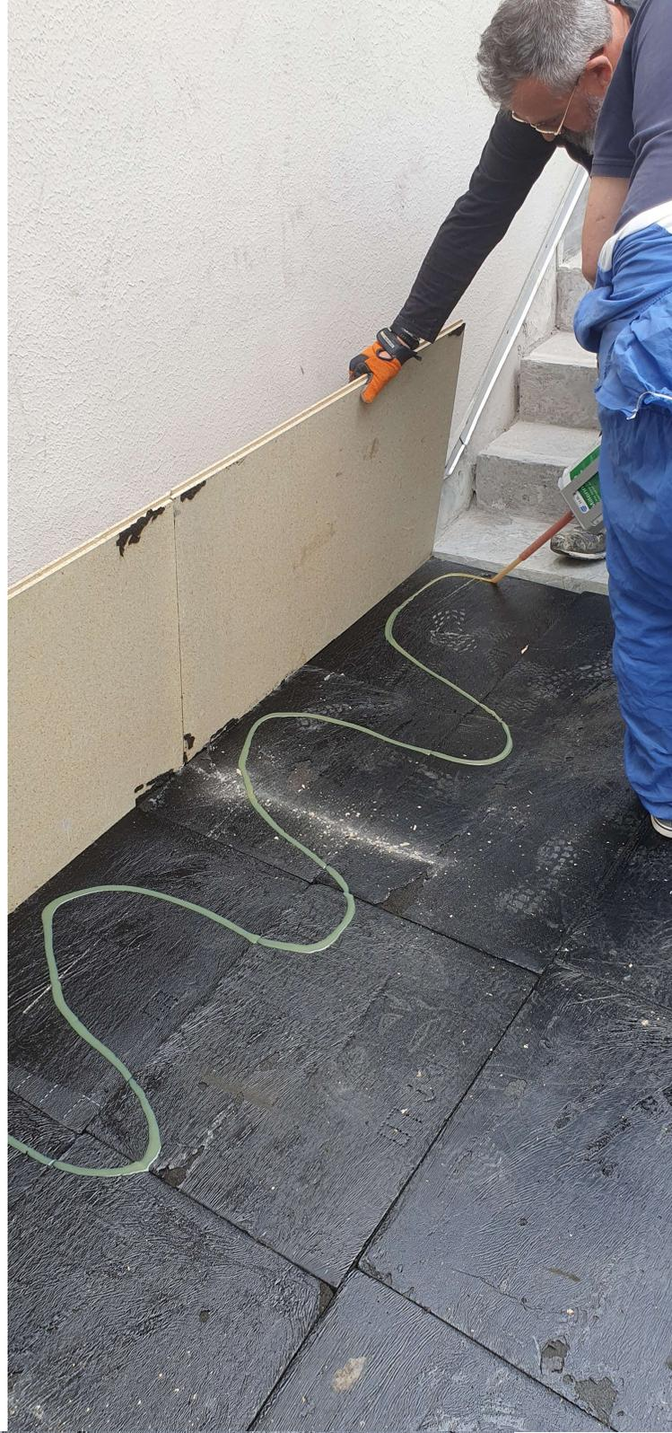
Les plaques AMROC sont équipées de joints rainurés bouvetés ce qui facilite la pose des panneaux
