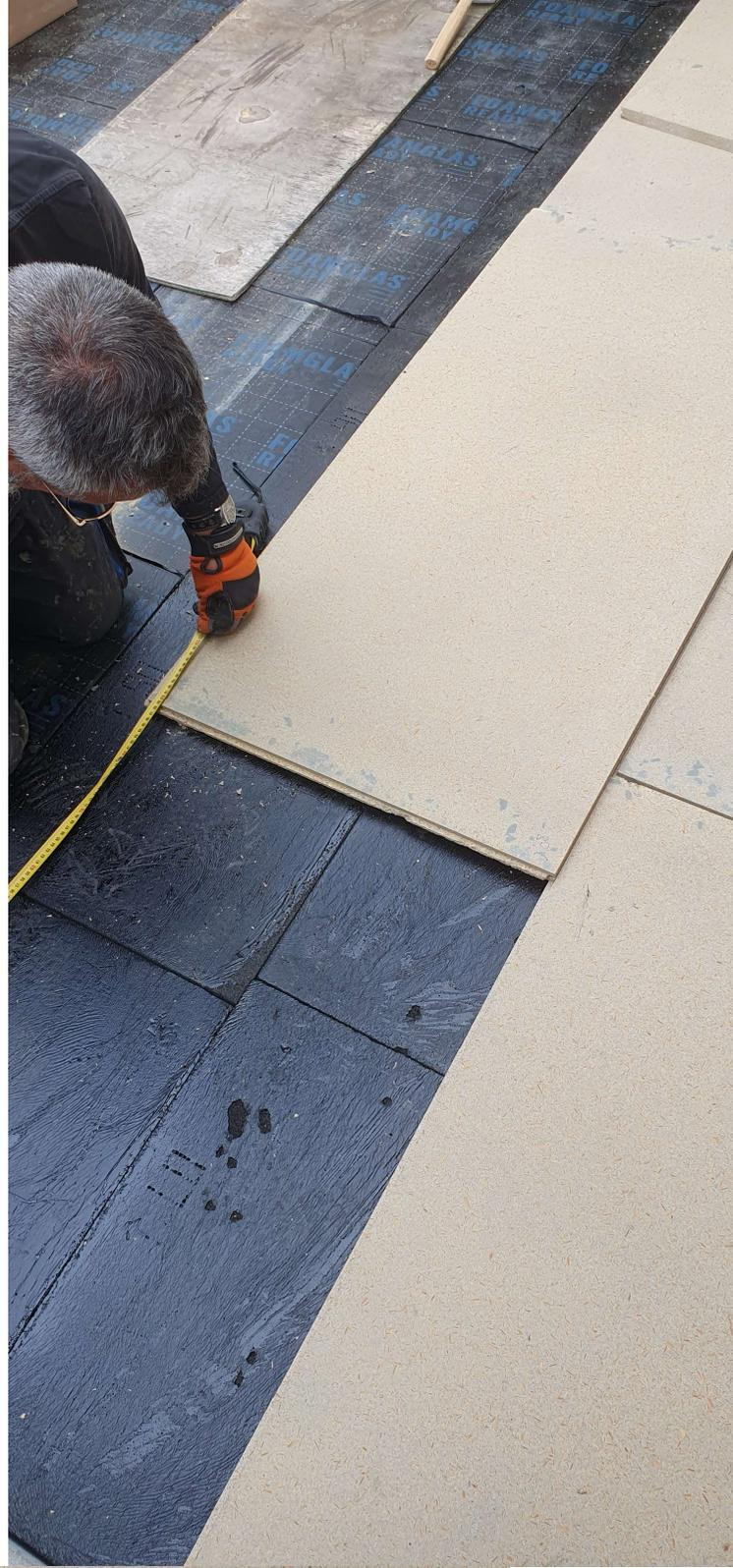
Une fois les panneaux AMROC posés à l'horizontal et à la vertical on aspire le support afin de pouvoir accueillir la solution TRIFLEX
