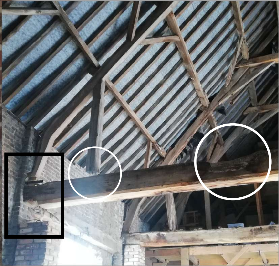
Poteau de descente de charge en brique dégradé, l'entrait s'est affaissé, le potelet n'est plus en contact avec celui-ci et présence de pourriture sur une partie de la pièce dû à une fuite dans la couverture.
