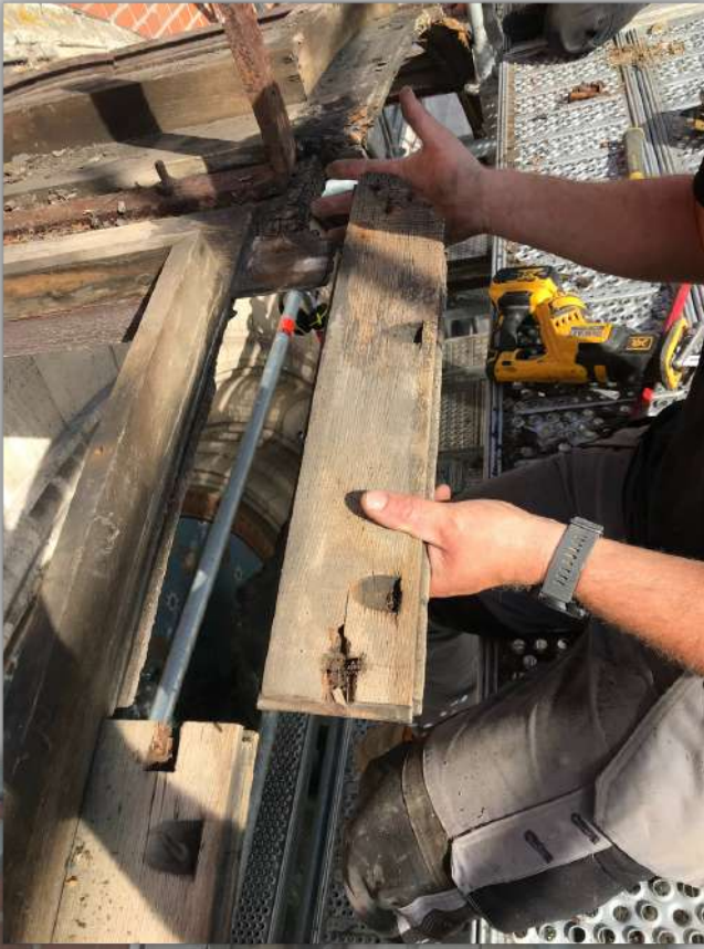
État de dégradation des corbeaux avancés.
