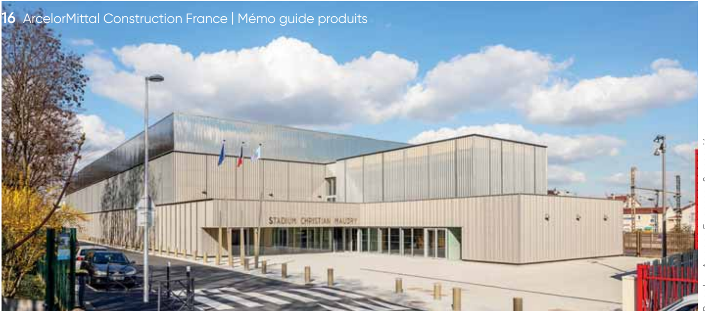
Eclectic® 7.61.50 en Pearl Gold Perla, Océane® 5.200.50 perforé en Solexcel® Mineral, ST300 en Inox Touch Gloss
