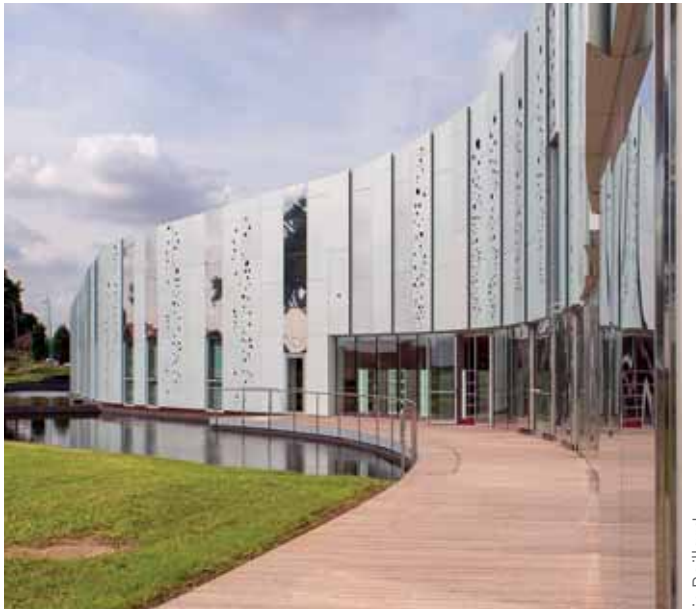
Coque MD® en aluminium post anodisé
