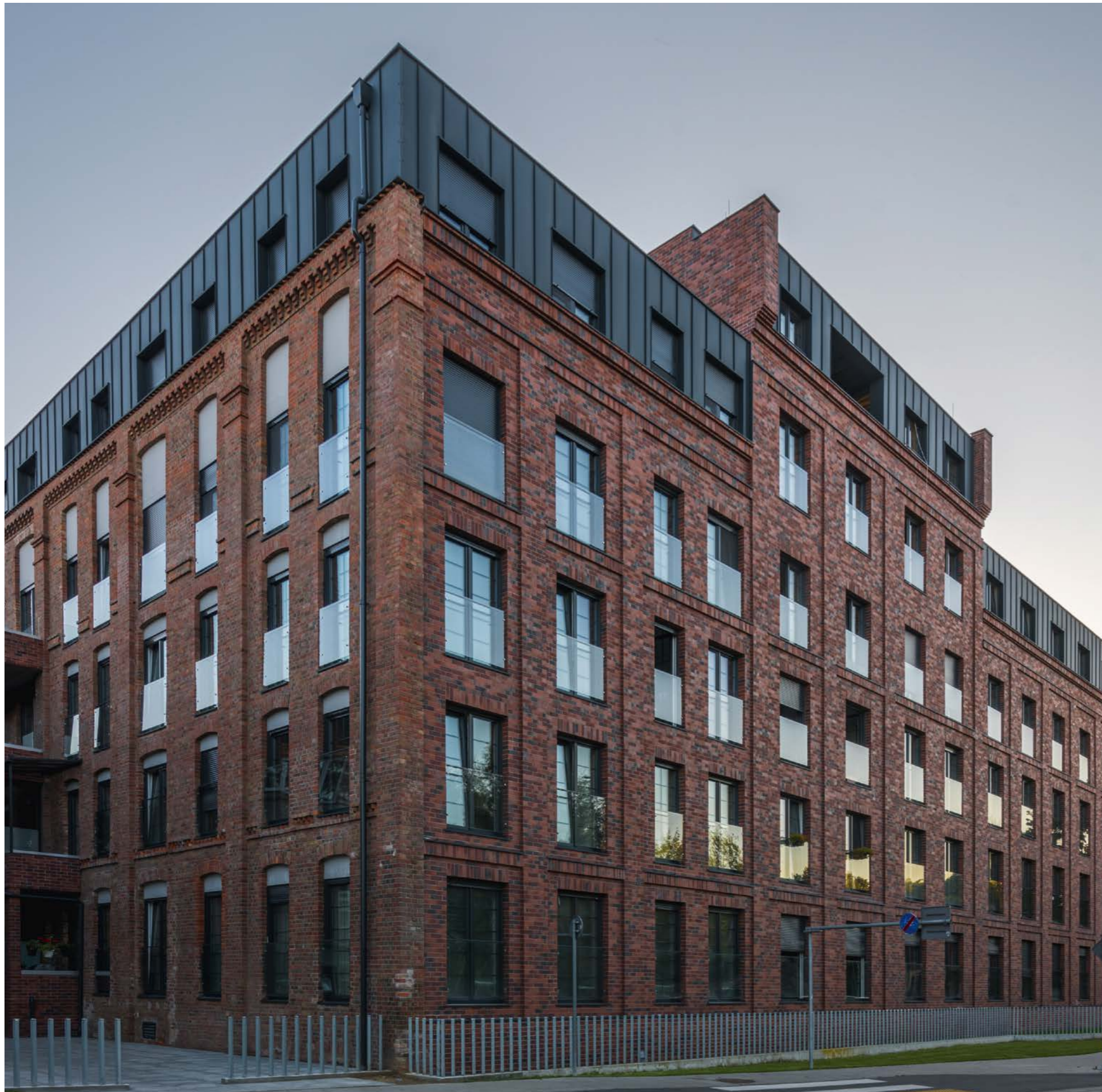
Bloki mieszkalne Młyn nad Cybiną, projekt: www.mconstructions.pl Inwestorzy: Grupa PARTNER, Przedsiębiorstwo R.Derda
