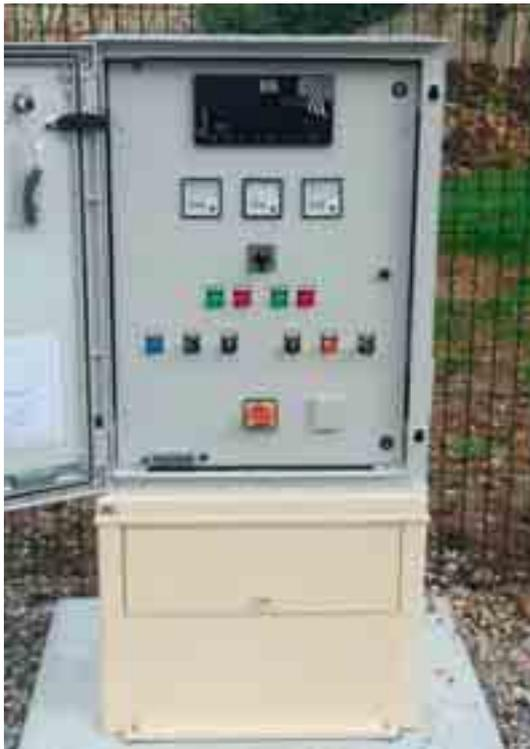
Armoire CPR pour poste de relevage
