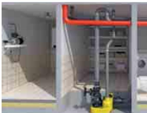
Les stations de relevage COMPLI sont idéales pour la pose de stations à l'intérieur des bâtiments même en zone inondable.
