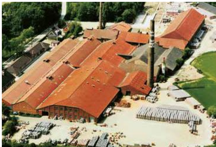
Usine de Schermbeck (Tuiles en terre cuite)
