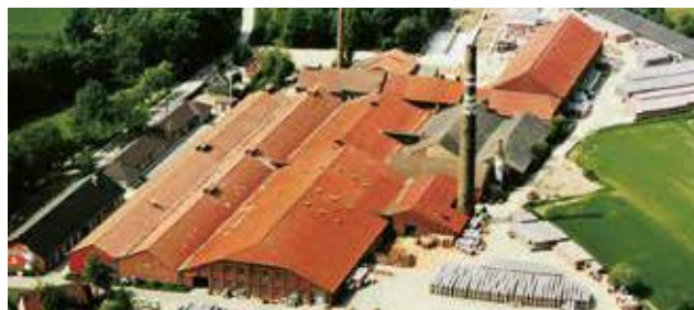
Usine de Schermbeck (Tuiles en terre cuite)
