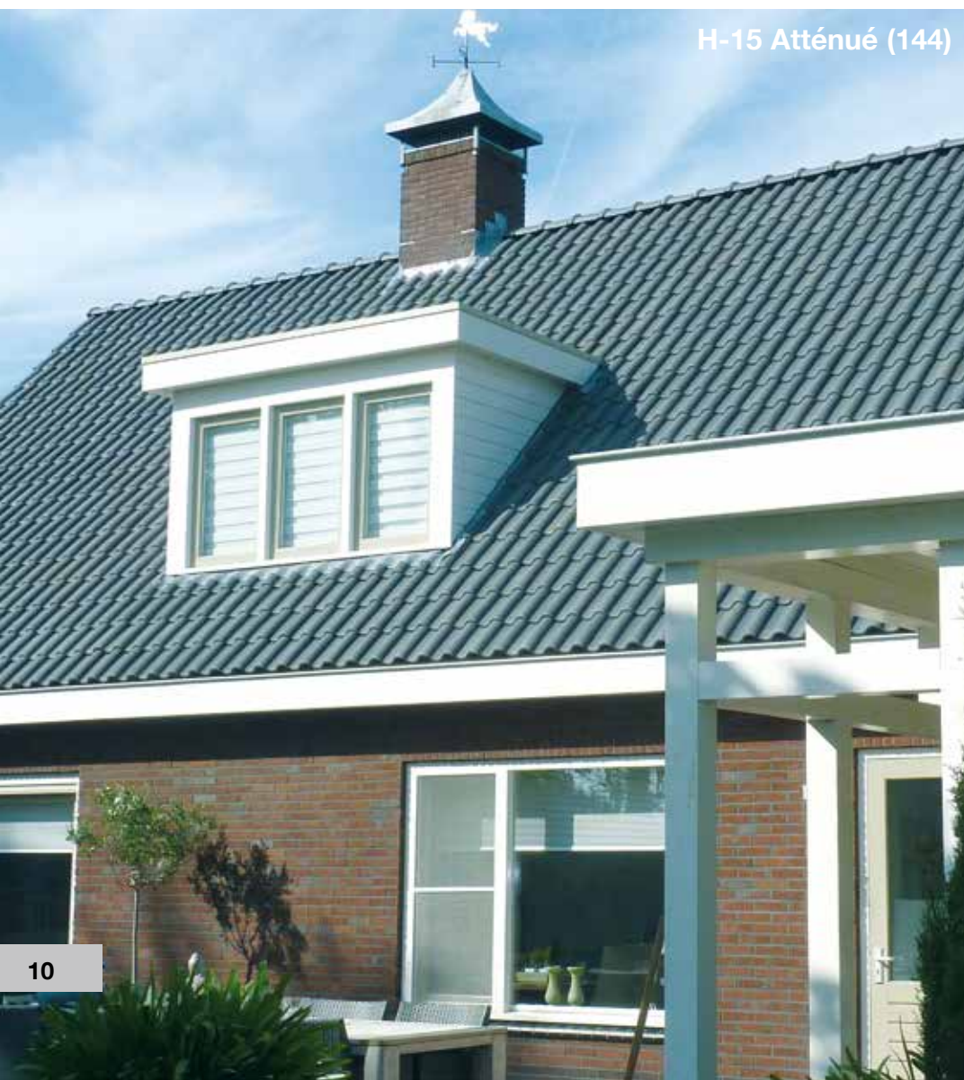
Tuile à emboîtement creux H15 Variable 14,6 – 15,5 pces/m 2
