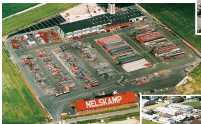
Usine de Schönerlinde (Tuiles de béton)
