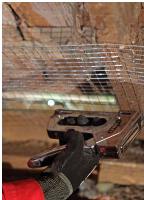
Découpe et pliage du grillage en correspondance des entrails (gauche) et maintien de l'aération (droite)
