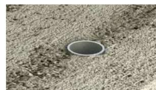
Le DAK affleure la face supérieure de la Dalle Alvéolée pour une fiabilité et une sécurité chantier optimales.
