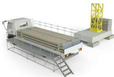
Les potelets garde-corps sont positionnés, en sécurité, avant le levage de la Dalle Alvéolée.
