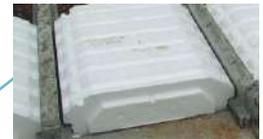
Emboîtement mâle qui permet un appui sur l'arase et une parfaite étanchéité entre entrevous pour le coffrage
