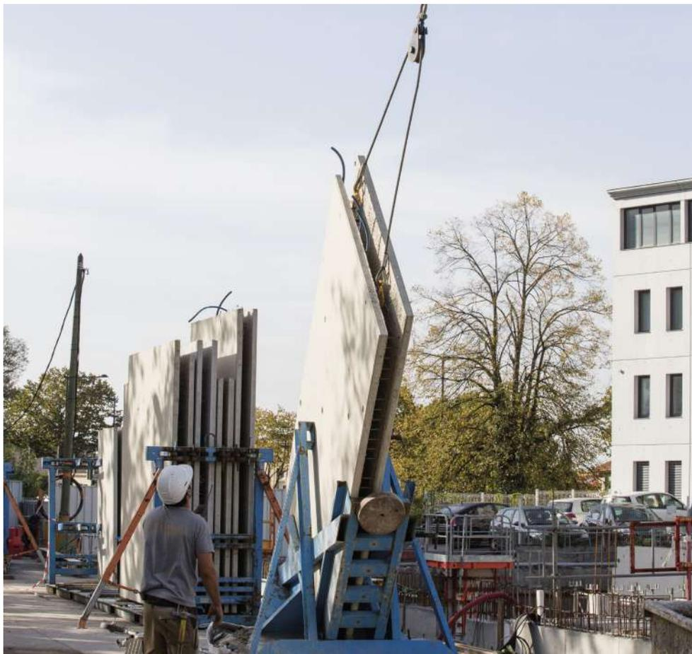
Le retournement des Prémurs est utilisé pour les Prémurs dont la hauteur est supérieure à 3,71 m. Ces Prémurs sont stockés à l'horizontale puis redressés sur chantier à l'aide d'un retourneur à axe libre type escargot.
