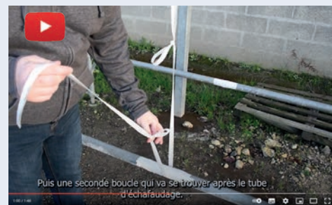
Tuto remplacement de tube par sangle disponible sur notre page youtube Alphatex
