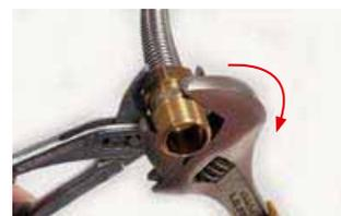
**6** Visser au maximum jusqu'au point de blocage avec les outils adaptés (permet l'écrasement de la matière).
