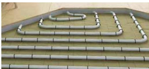
Pour la pose sur isolant plan, fixer les agrafes (3 par mètre de tube environ) à l'aide de l'agrafeuse.
