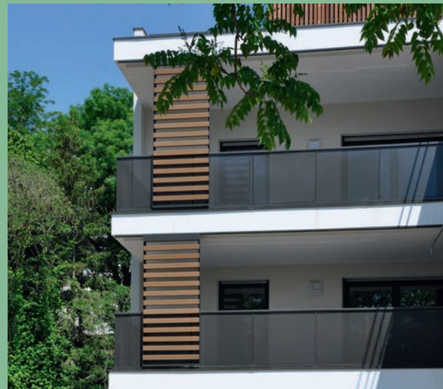
SPACE 6 - Teinte Sun • Architecte : Atelier Thierry Roche
