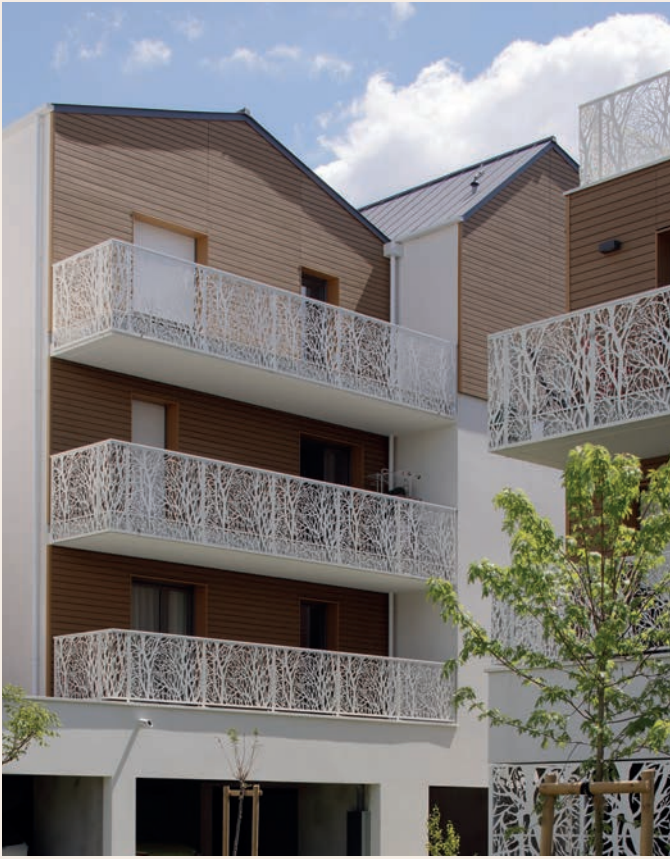
Logement collectif - Le Carré Silva - St Herblain (44) - SMART 9 - Teinte Sun Architecte : Mark Guegan / Atelier 26
