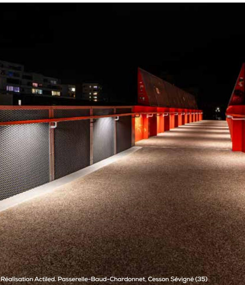
Luminaire à LED pour intégration dans une main courante de section ronde ou carrée. Disponible en longueur de 5001 mm et deux niveaux de puissance, ce luminaire est chainé par câblage traversant jusqu'à 200m. Raccordement direct au 230V sans driver externe, rapide à installer. Une version avec faisceau accentué 40° est disponible pour un éclairage plus directif.
