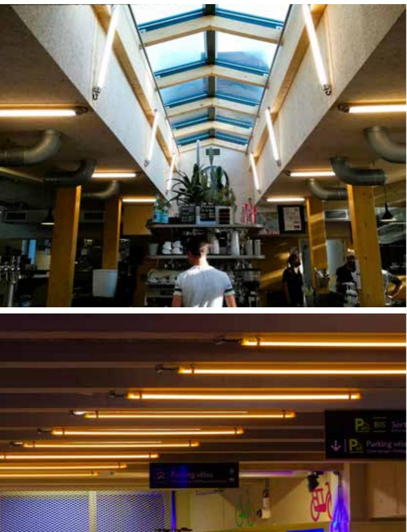
Tubulaire à LED 230V Ø40 mm finition inox. Idéal pour l'éclairage extérieur de mise en valeur, de balisage, de circulations ou architectural, l'éclairage tertiaire de lieux de travail et de vie, de halls et de circulations, de zones techniques et de parkings.
