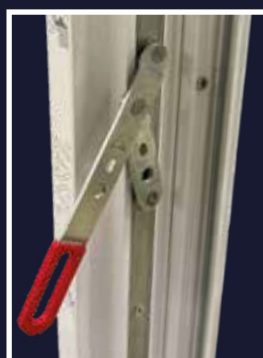
Compression et sécurité doublée grâce à la crémonne du semi-fixe en cas d'oscillo-battant
