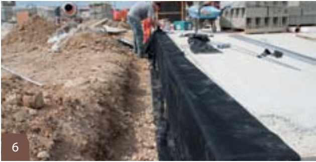
Ajustement de la protection de soubassement en EPDM avant fixation
