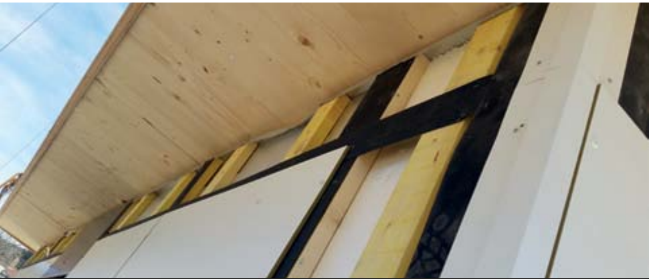
Pose de bandes EPDM pour l'étanchéité des menuiseries
