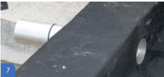
7 Positionnement de la bague de sertissage des descentes d'eaux pluviales
