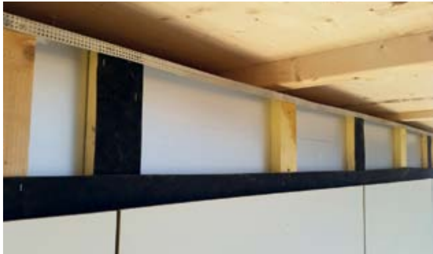
Bande de protection pour ossature bois sous bardage rapporté
