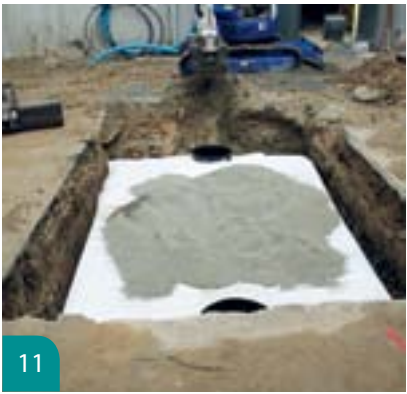
11 Finalisation du bassin enterré et recouvrement
