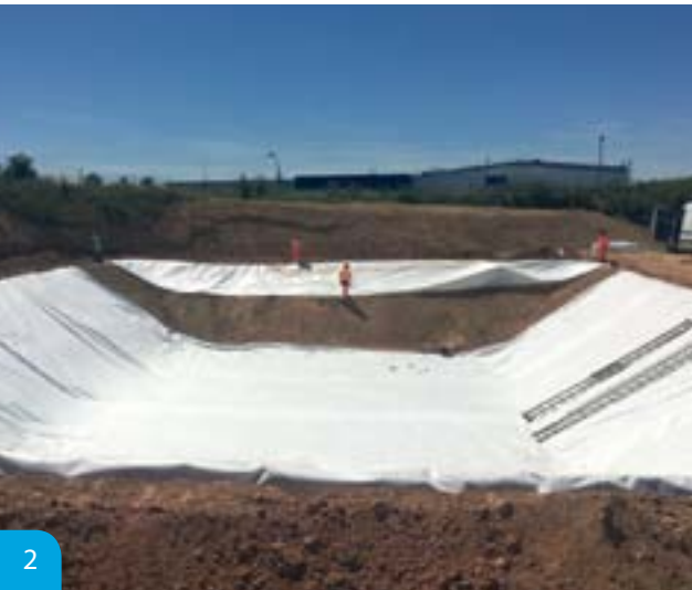
Terrassement réalisé, préparation de la surface et pose/agrafage du géotextile
