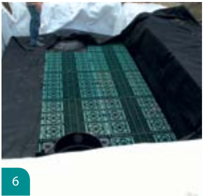
6 Fin de l'installation des casiers et positionnement des rabats de la géomembrane EPDM 3D
