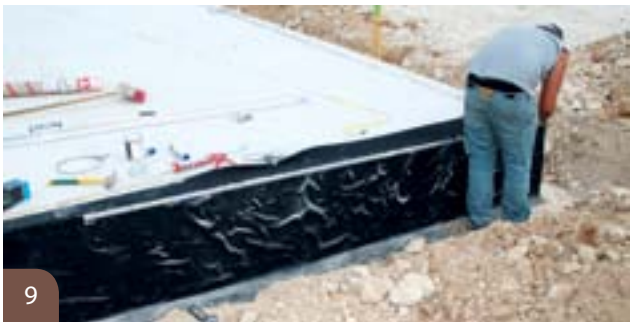
Mise en place d'un cordon de mastic pour sécuriser l'étanchéité au niveau du profil de fixation
