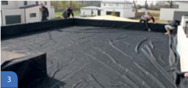
3 Positionnement et ajustement de la membrane avant fixation
