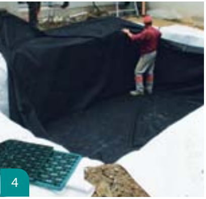
4 Déploiement de la géomembrane EPDM 3D
