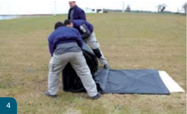
Déploiement de la citerne souple
