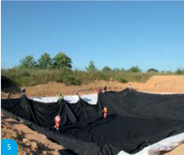
Ajustements de la géomembrane
