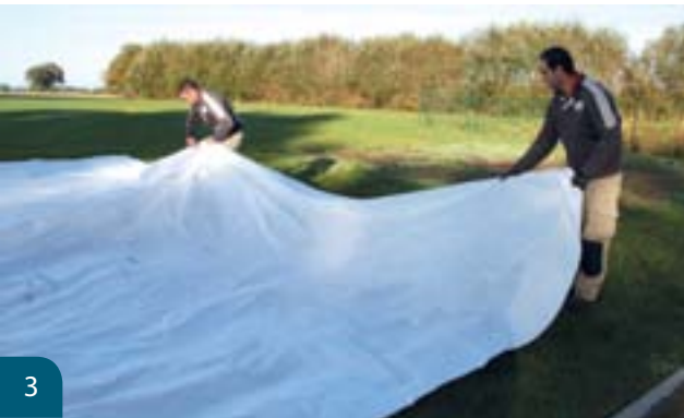
Pose du géotextile de protection avec agrafages
