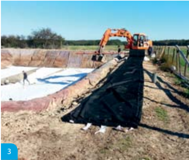
Positionnement et déroulement de la géomembrane en haut de talus
