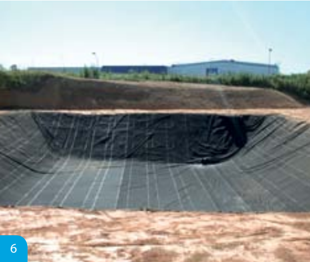
Ancrage et bassin finalisé
