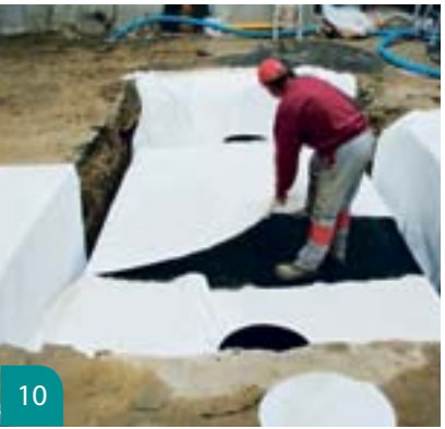
10 Pose du géotextile extérieur
