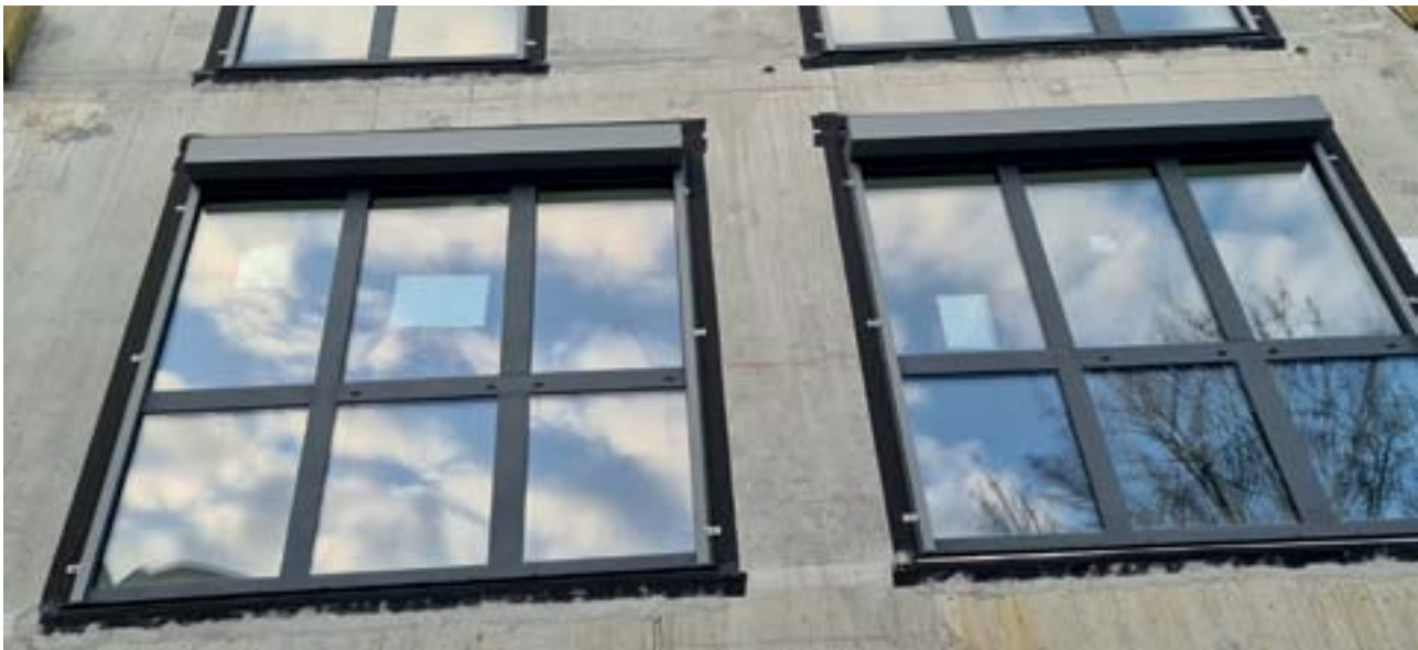
Pose de bandes EPDM autocollantes pour l'étanchéité des menuiseries dans le cadre d'une ITE
