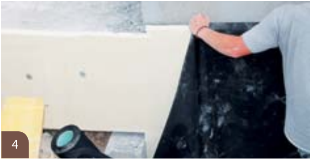
Déroulement de la protection de soubassement en EPDM
