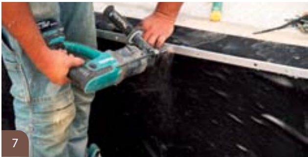
Positionnement du profil de fixation et perçage
