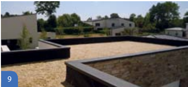
9 Mise en place du géotextile puis du gravier pour lestage final
