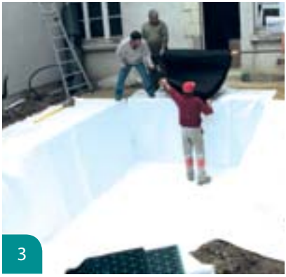
3 Déroulement de la géomembrane EPDM 3D
