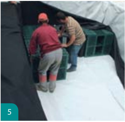
5 Pose du géotextile de protection intérieure et installation de modules
