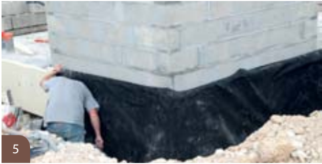
Positionnement de la protection de soubassement en EPDM
