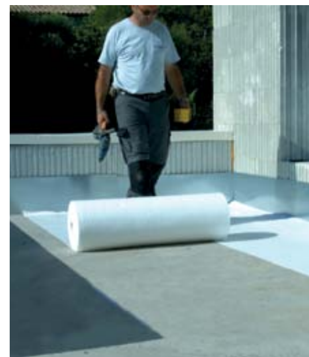
GÉOTEXTILE DE PROTECTION
