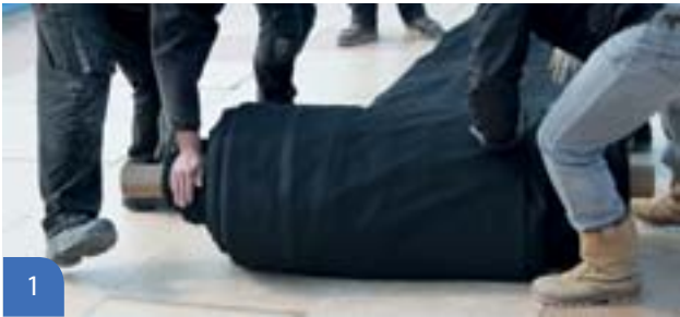
1 Déroulement de la membrane
