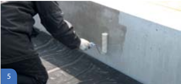
5 Encollage des relevés d'étanchéité
