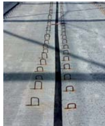
Étanchéité entre joints de prédalles
