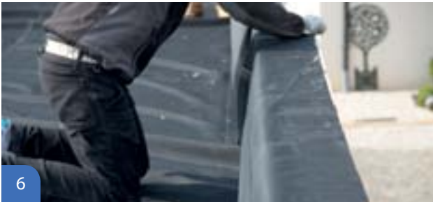
6 Collage et marouflage de la membrane sur le support
