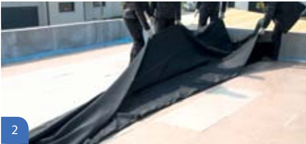
2 Dépliage de la membrane
