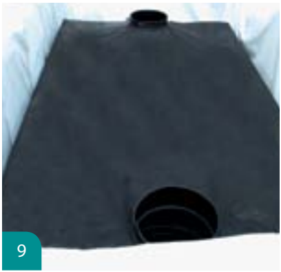
9 Découpage et positionnement des collerettes de sortie
