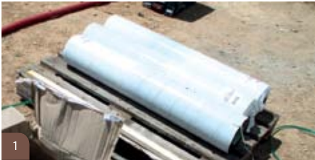
Livraison de la protection de soubassement en EPDM
