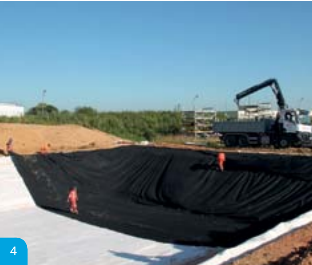
Dépliage de la géomembrane
