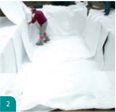
2 Pose du géotextile de protection extérieure
