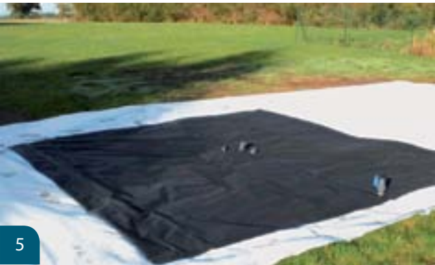
Mise en place de la citerne sur le géotextile
