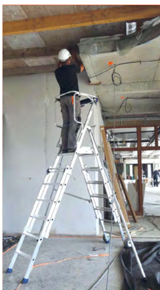
Plateforme télescopique de 4,33m (réf. TANDEM XT 9)
