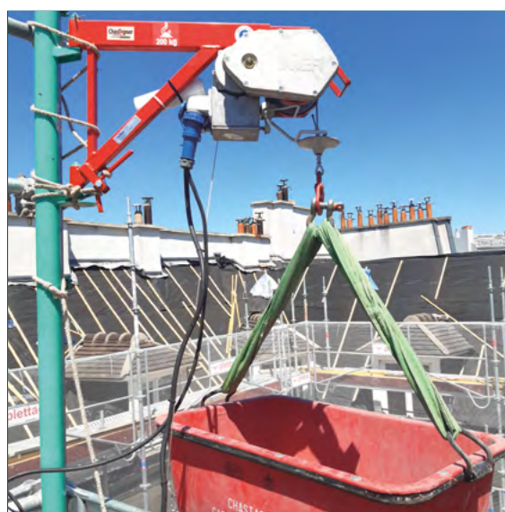
Treuil potence télescopique avec bac à mortier (réf. TR 225)
