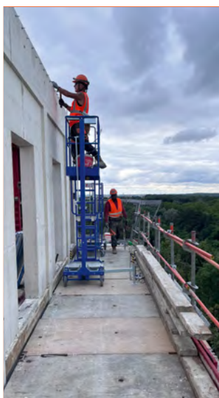
Ixolift hauteur de travail 3,97m (réf. Ixolift X400WS)
