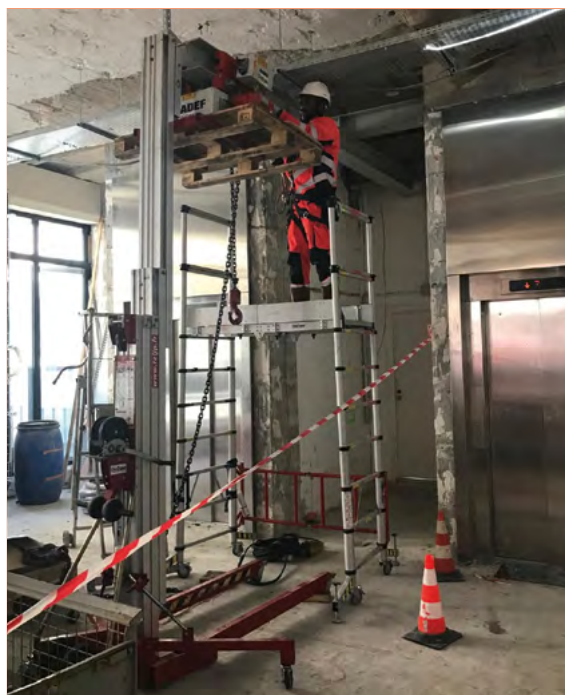
Élévateur télescopique 450 kg / 3,5m (réf. ELEVATEUR LGM 10)
