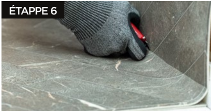
ÉTAPE 6 Lorsque le matériau est bien à plat au niveau des raccords et des angles, la coupe finale le long des murs peut être effectuée.
