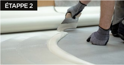
ÉTAPE 2 Appliquer la colle sur le support conformément aux instructions du fabricant de colle.
