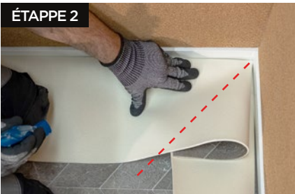
ÉTAPE 2 Placez la pointe de votre lame dans le coin et découpez jusqu'à l'extérieur.
