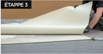
ÉTAPE 3 Attendez le temps de séchage recommandé, puis repositionnez le revêtement de sol sur le support.
