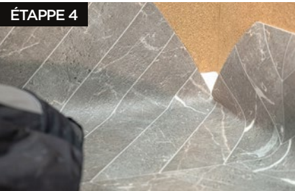
ÉTAPE 4 Découpez la section comme indiqué. Une fois terminé, ouvrez pour vérifier si la coupe de l'angle est parfaite.
