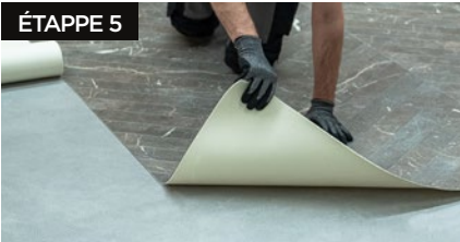
ÉTAPE 5 Répéter la même opération avec les autres lés en veillant à ne pas superposer la colle.
